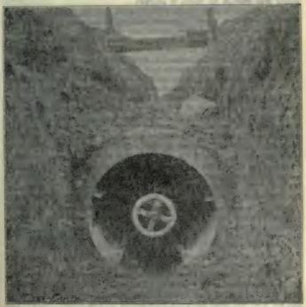
Fig. 15 .- Centers for Concrete Sewer.
